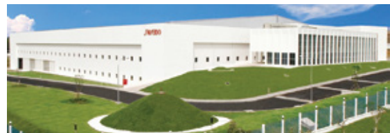
2009 - 資生堂 ベトナム工場
