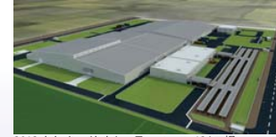
2013 キヤノンベトナム ティエンソン13A工場
