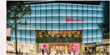
2016 ホーチミン高島屋 内装工事
