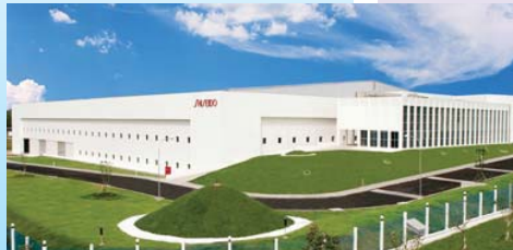
2009 資生堂ベトナム工場
