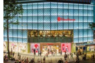
2016 ホーチミン高島屋 内装工事
