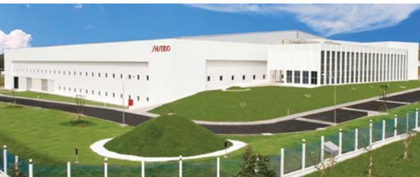
2009 資生堂ベトナム工場
